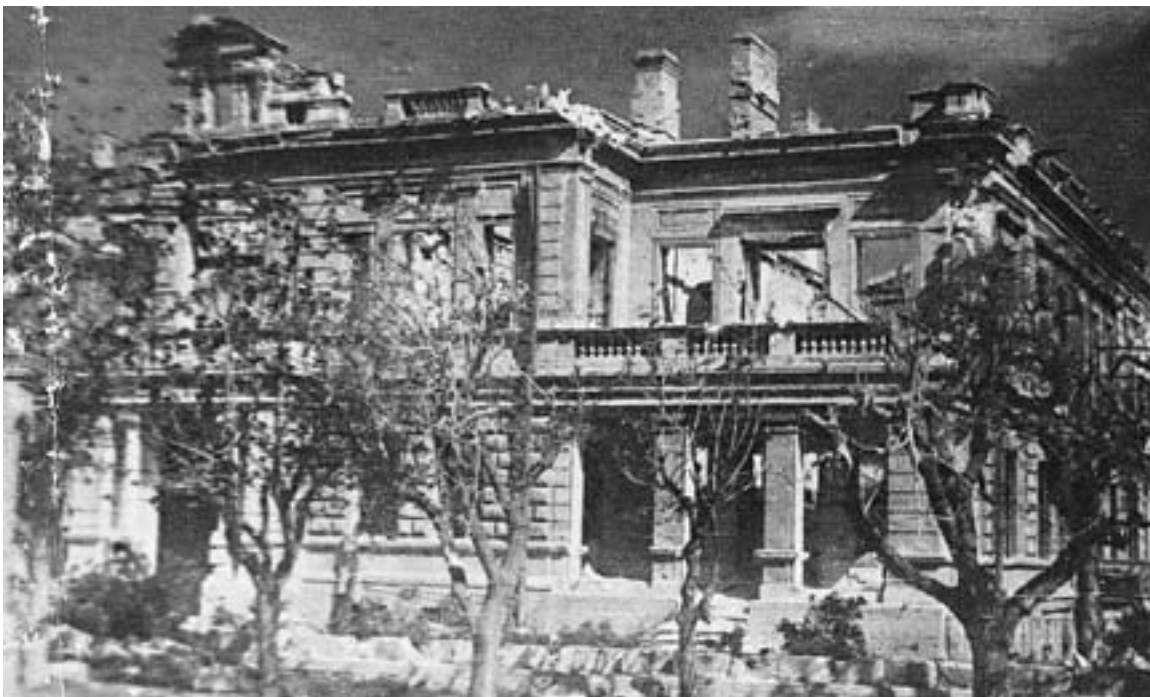
Фото разрушений в районах вблизи Севастополя и в городе
